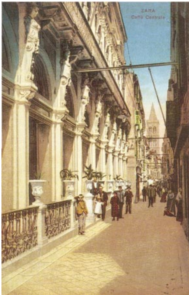
Sl. 15. Zadar, pročelje Gradske kavane na Kalelargi (poč. 20. st.)
